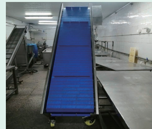
The hoist installed 提升機已安裝完成
